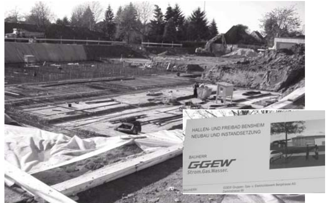
Frei- u. Hallenbad bleiben am alten Standort: Die Baustelle Anfang Dezember 2003
